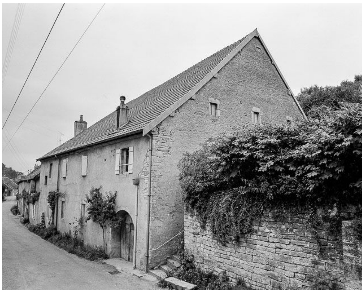
Maison située 7 chemin des Ecoliers.
