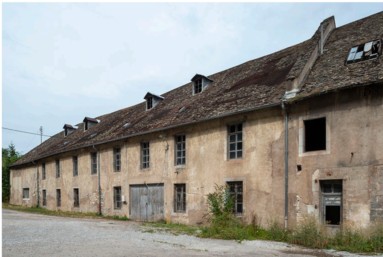
Façade sud de l'atelier de fonderie.
