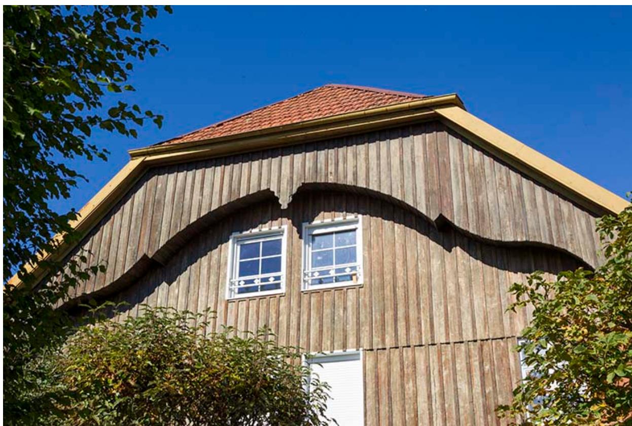
Ferme, façade latérale gauche : lambrichure et rang-pendu.
