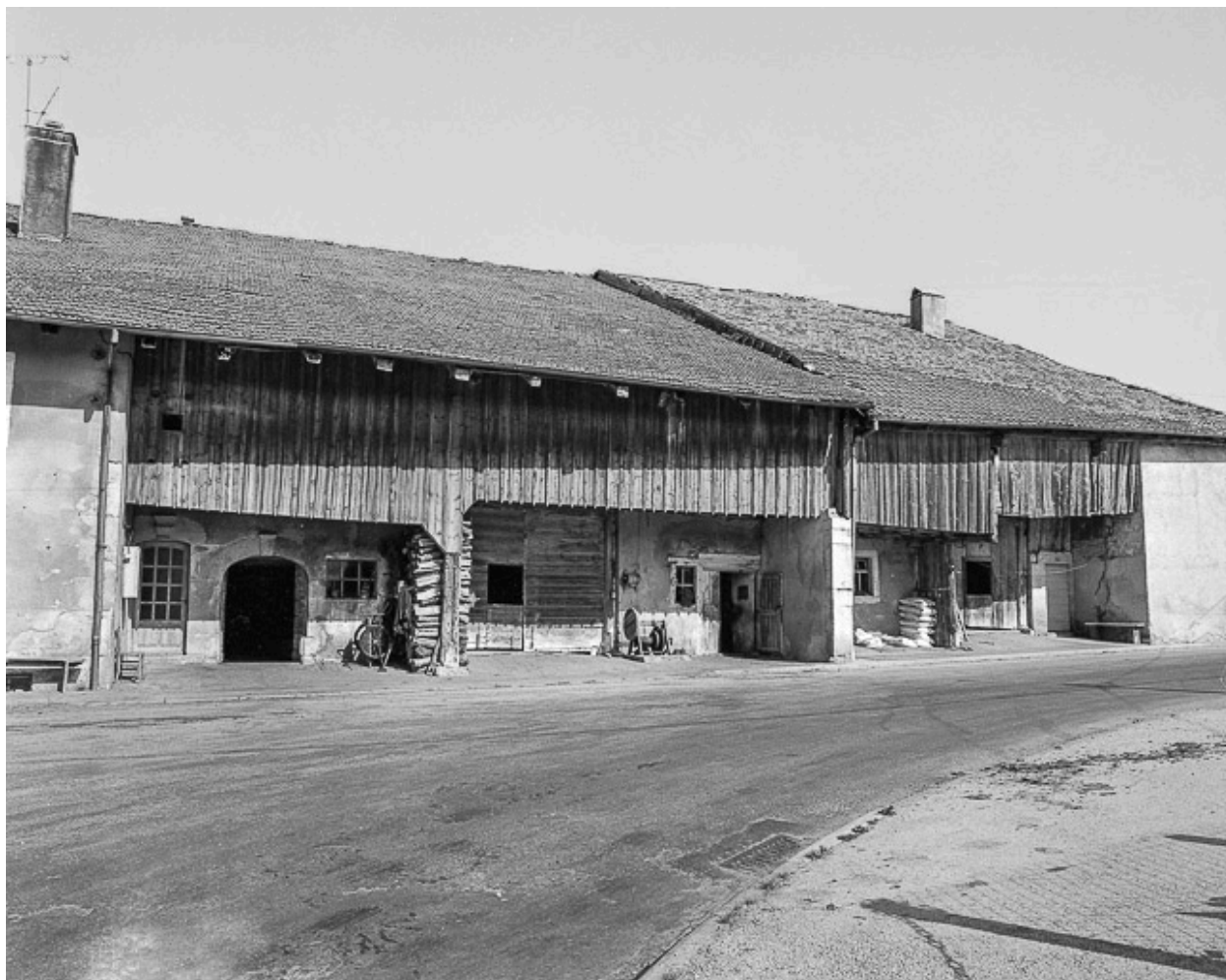
Goutterot sur rue.
