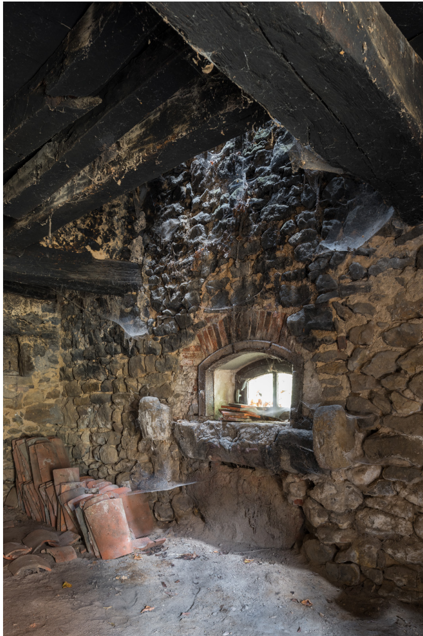
Vue intérieure du pignon ouest de la dépendance.
