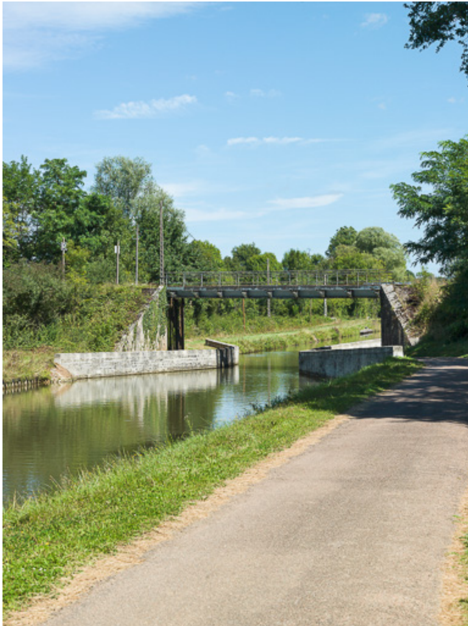
Vue d'ensemble du pont.
