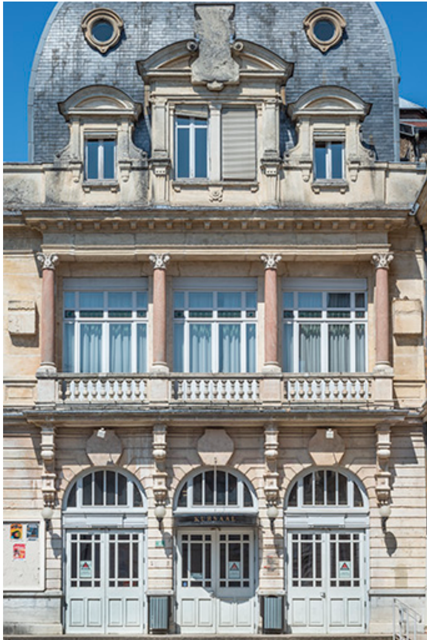
Bâtiment d'entrée, façade antérieure (vue resserrée).
