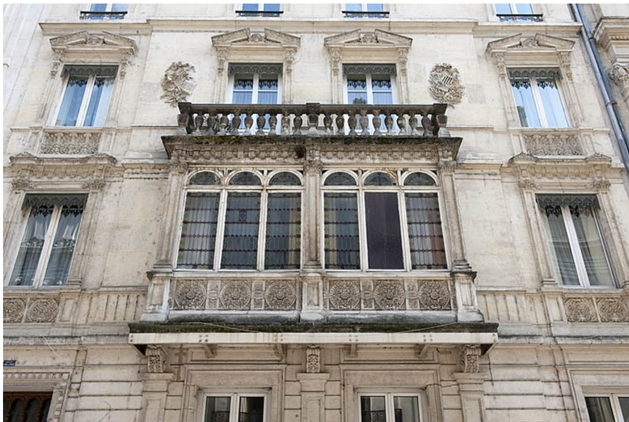
Façade antérieure : détail du bow-window de face.
