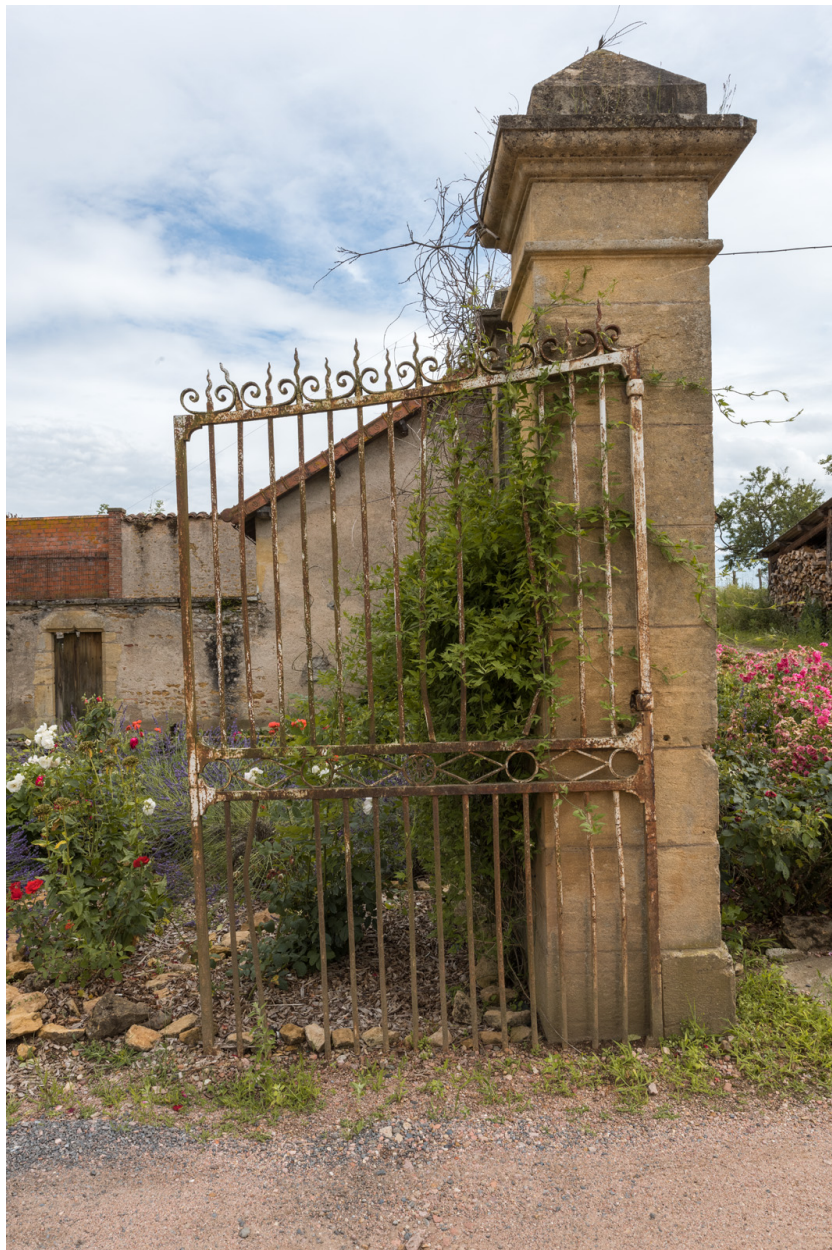
Détail du portail d'entrée de la demeure.
