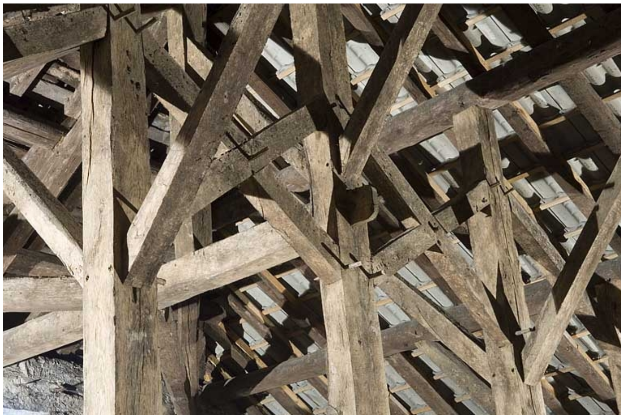
Charpente du fenil. Détail de partie haute.
