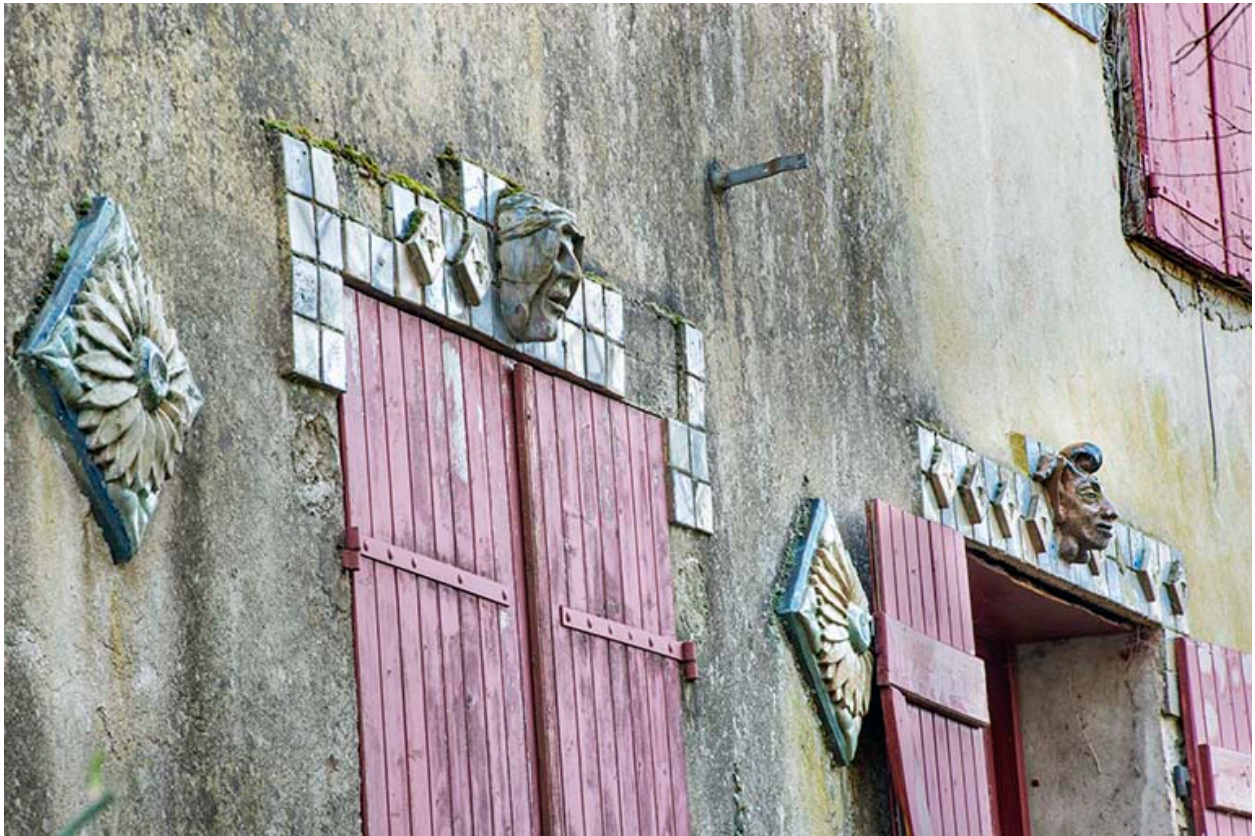
Façade ouest. Éléments de décor.
