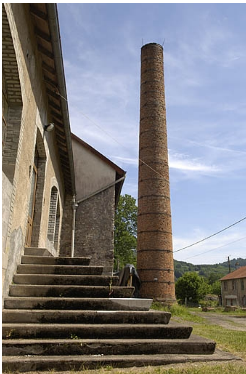
Escalier sur la façade postérieure et cheminée.
