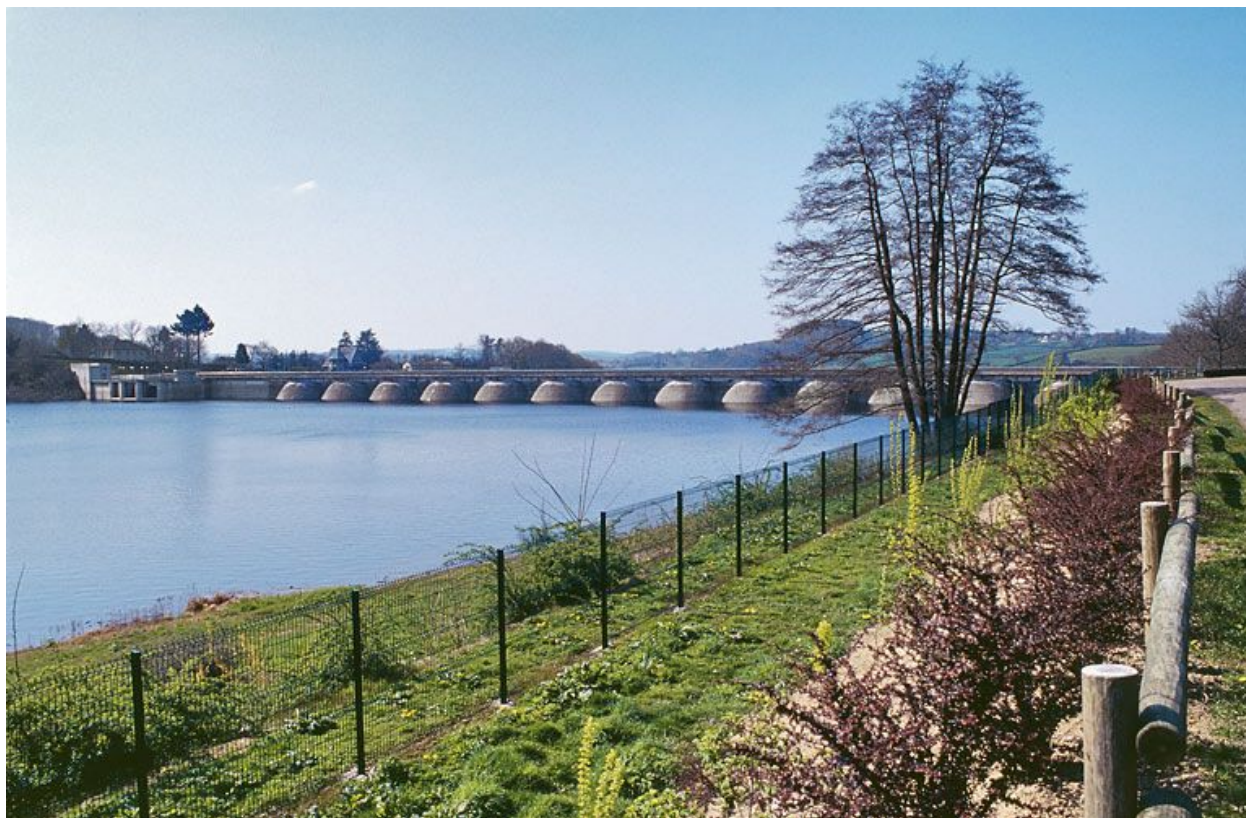
Le barrage, vue d'ensemble d'amont.
