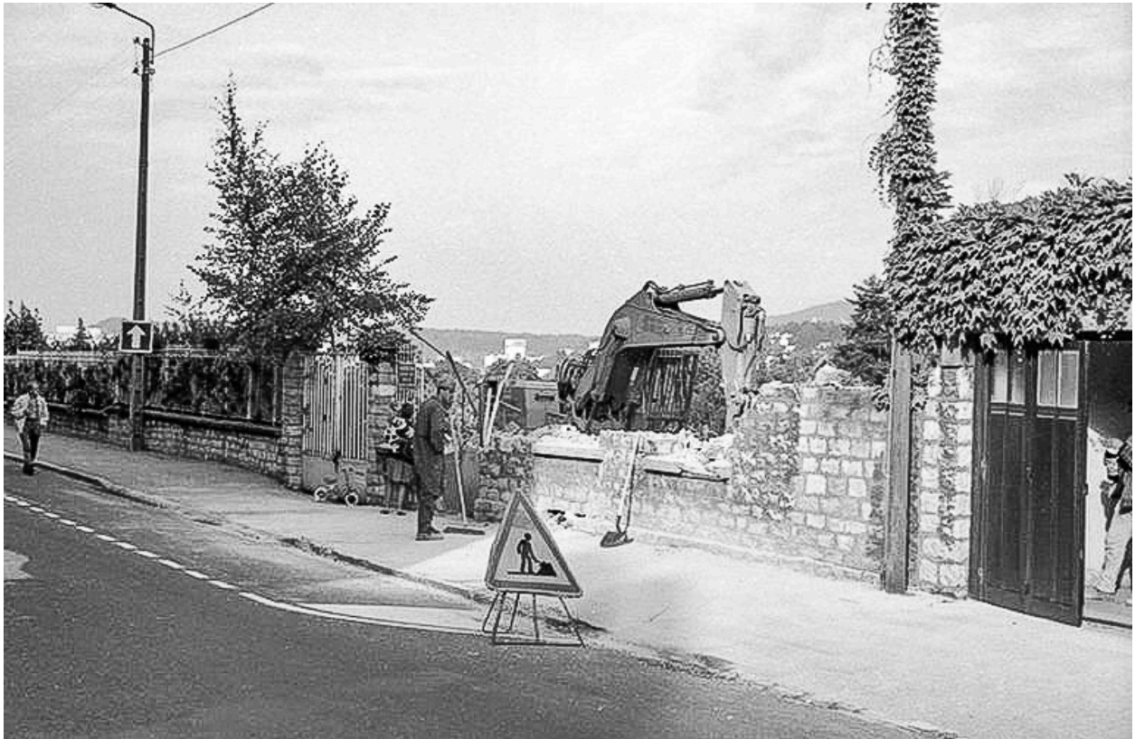
Destruction de l'usine, 24 août 1993 au soir : pelle mécanique et ouvrier.
