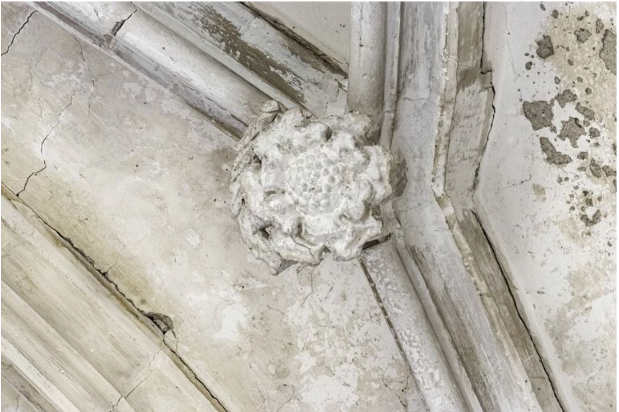
Intérieur de la chapelle : clef de voûte du choeur.
