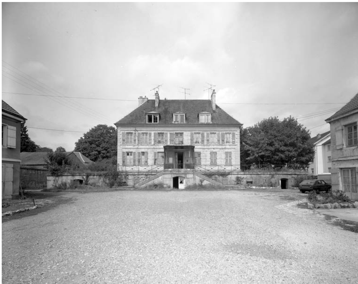
Habitation : façade antérieure de face.
