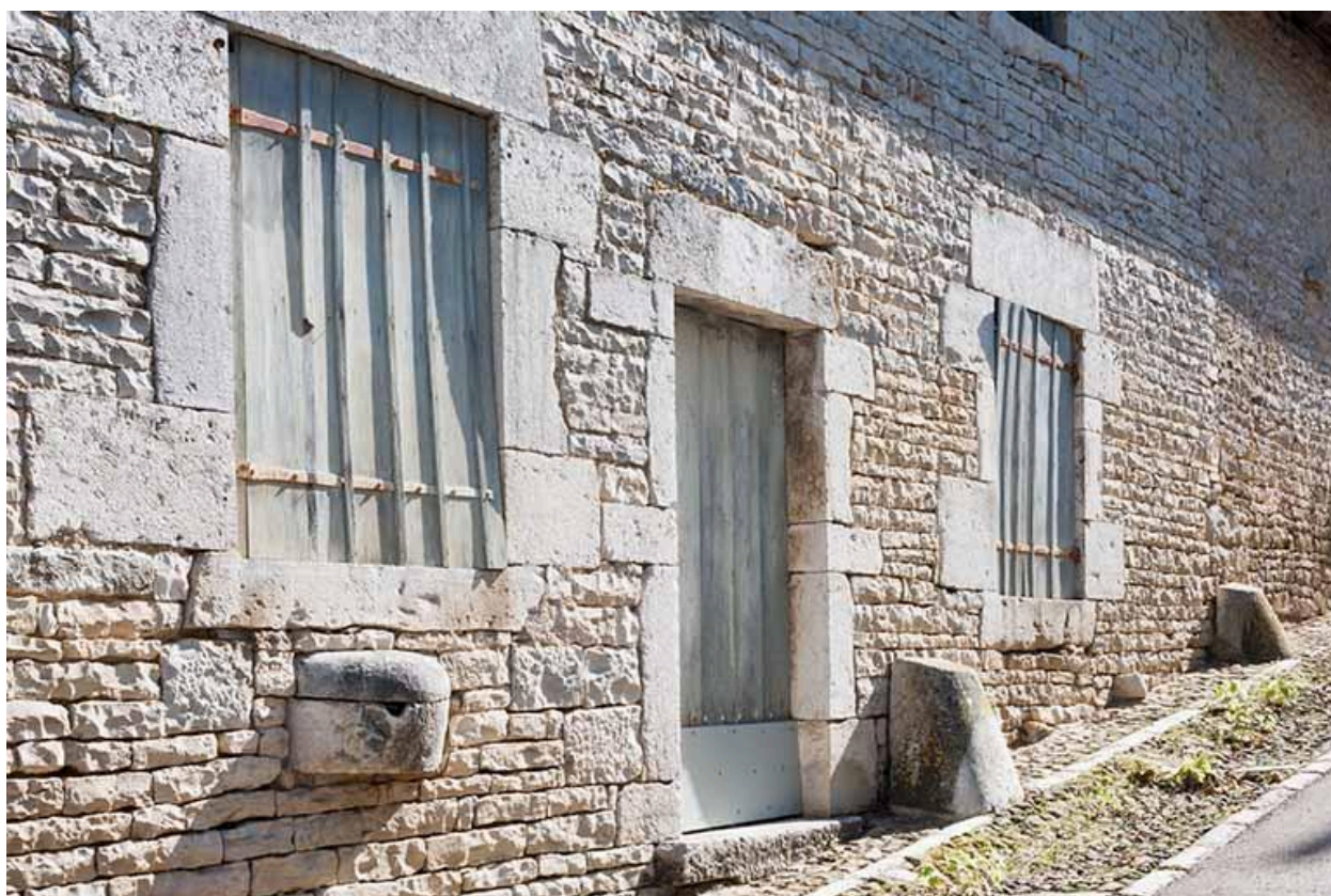
Baies de la façade ouest
