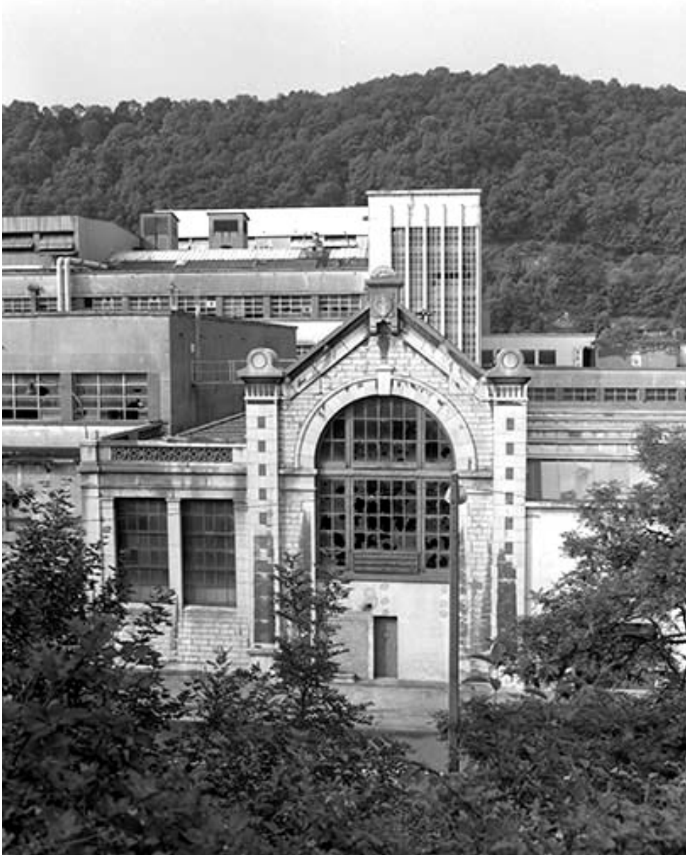
Façade sur rue de la chaufferie (P, ancienne centrale thermique).
