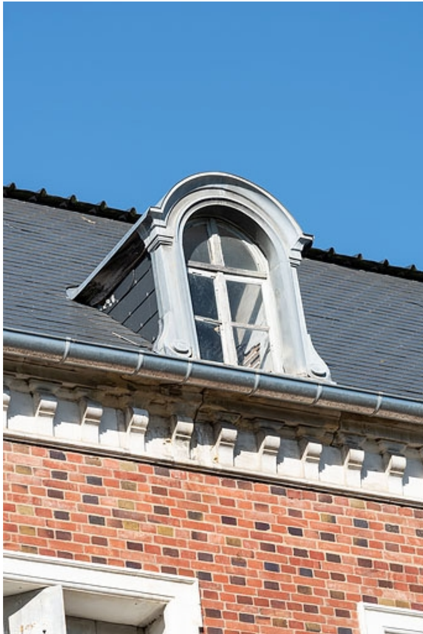
Façade de l'extension de Jules Guimard, lucarne.
