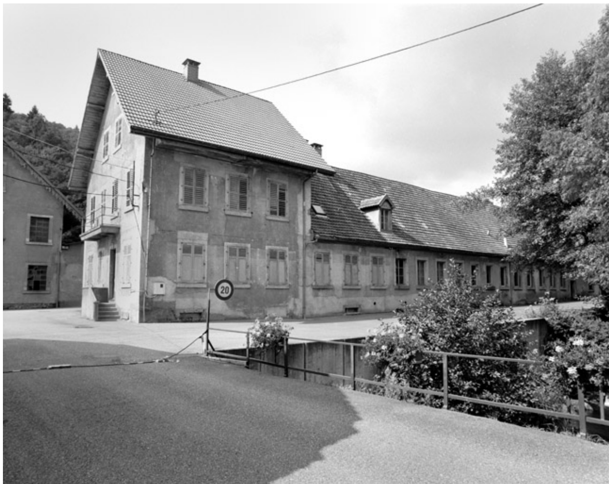
Bureaux et conciergerie depuis l'entrée.
