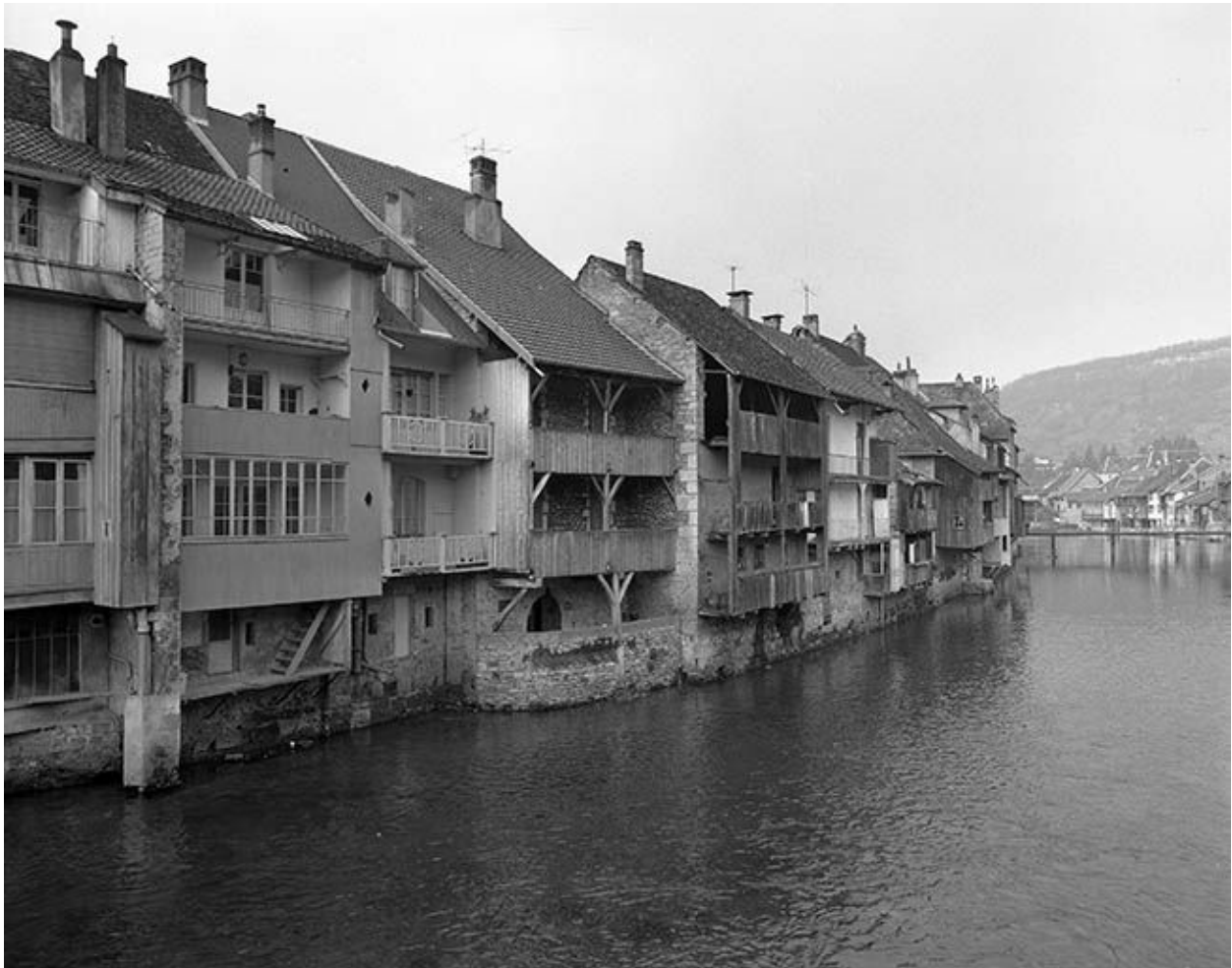
Façades postérieures des maisons de la rue Saint-Laurent depuis le grand pont, vue générale rapprochée.
