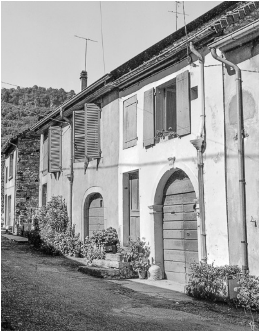
Fermes : façades sur rue.
