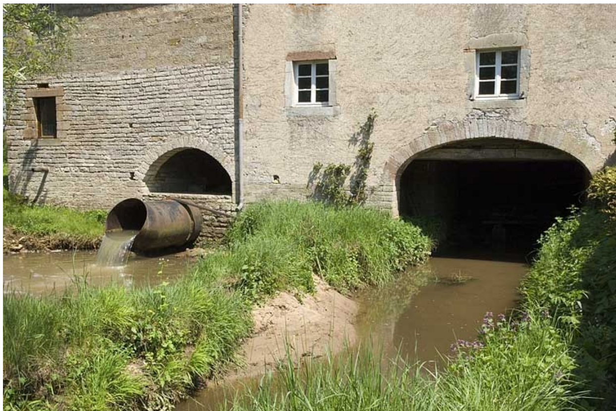
Canal de fuite.
