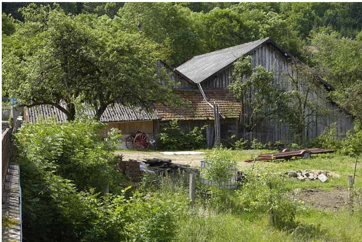
Pignons de l'atelier de scierie.
