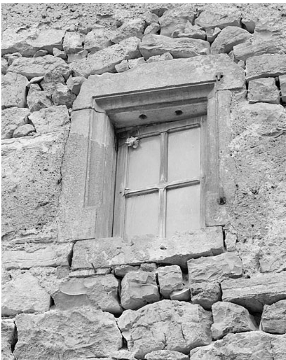
Détail d'une fenêtre sur la façade postérieure.
