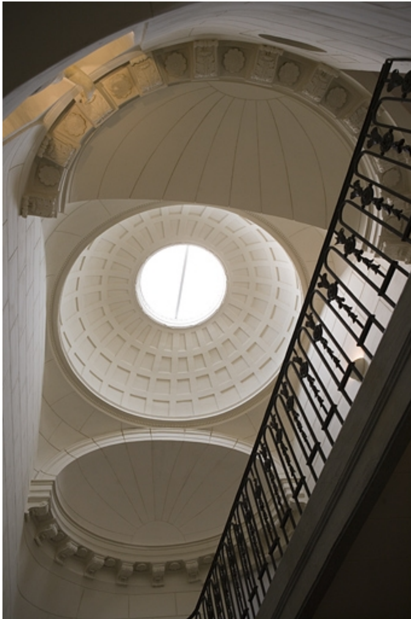
Couvrement de l'escalier : détail de la coupole et des deux demi-coupoles.
