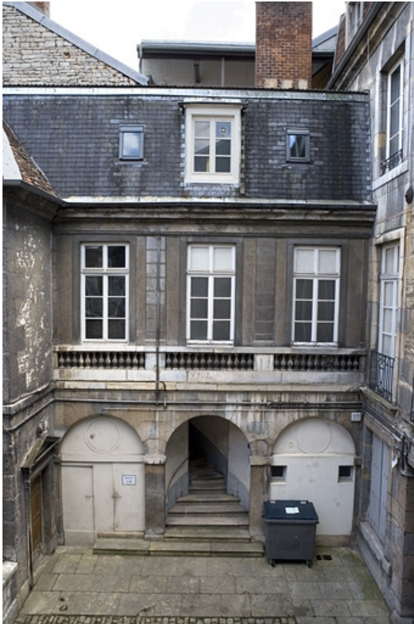
Vue éloignée de face de l'aile droite dans la première cour.
