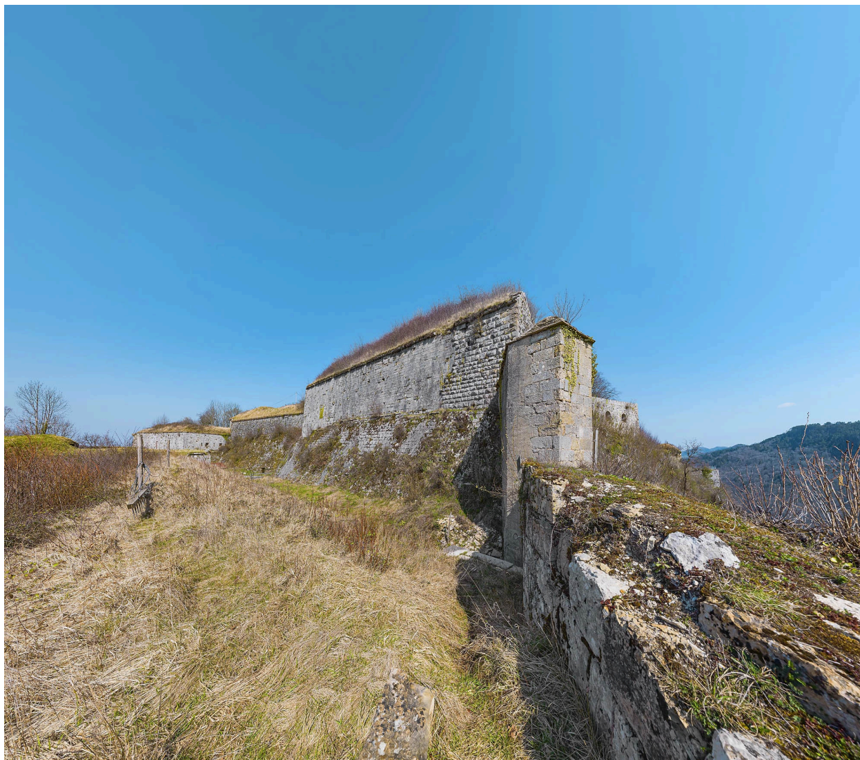
Remparts : angle sud-est.
