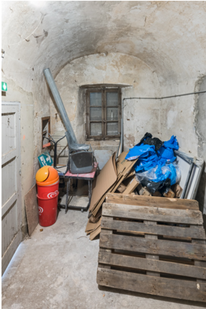
Corps nord-ouest : pièce voûtée au rez-de-chaussée.
