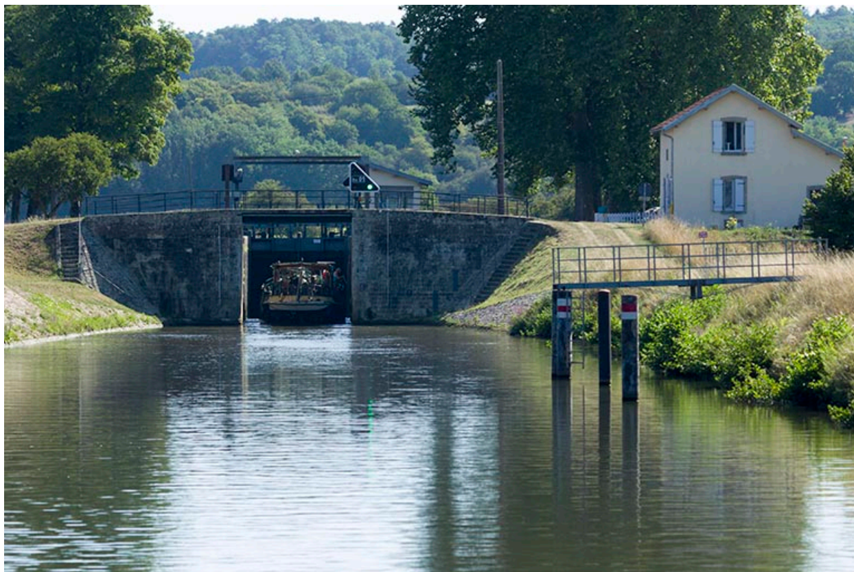
Site d'écluse, Ormoy.
