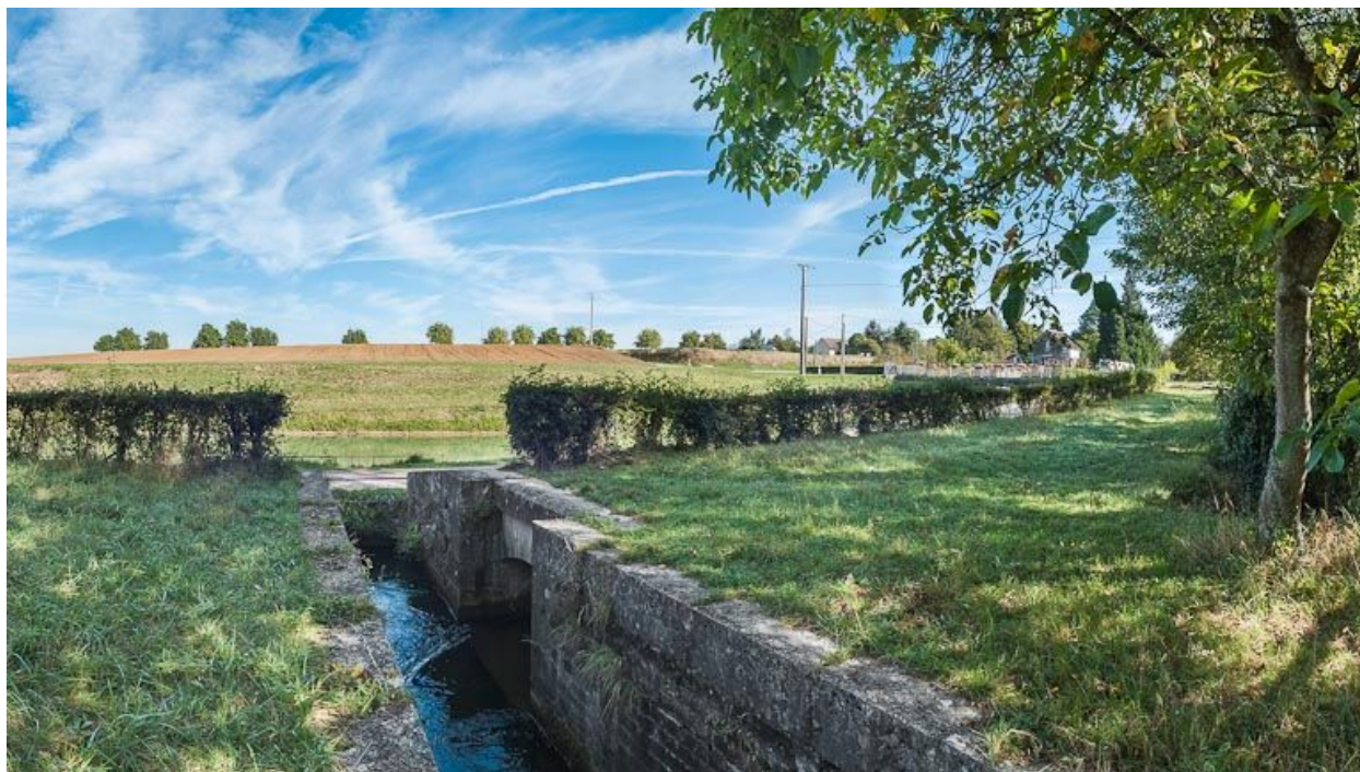
Détail de maçonnerie de la rigole.
