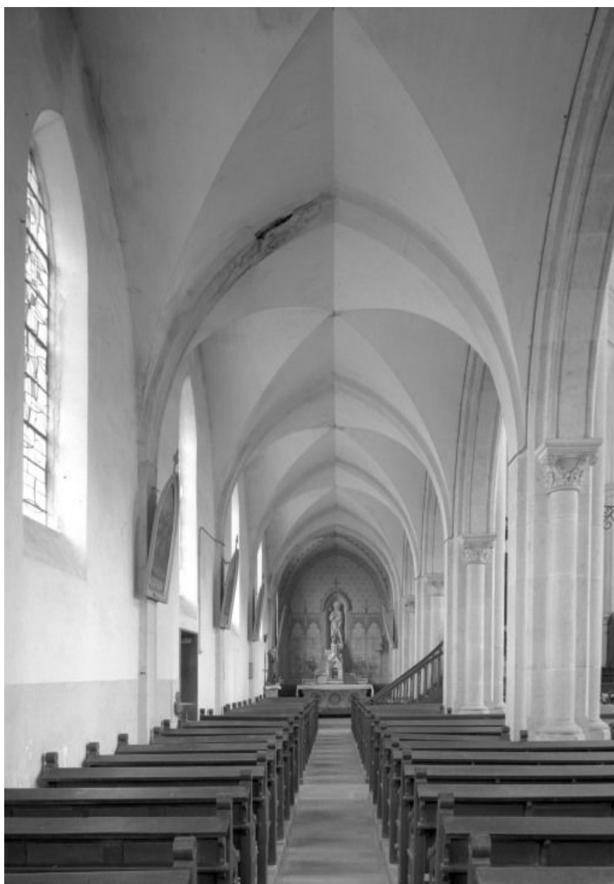
Collatéral gauche, vue prise depuis l'entrée
