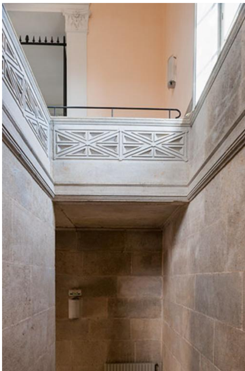
Balustrade de l'escalier
