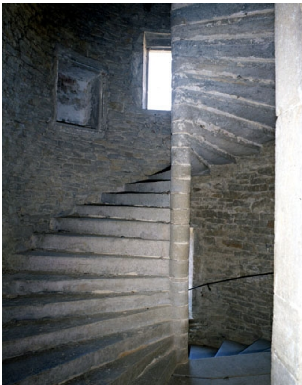
Escalier en vis de la tourelle.
