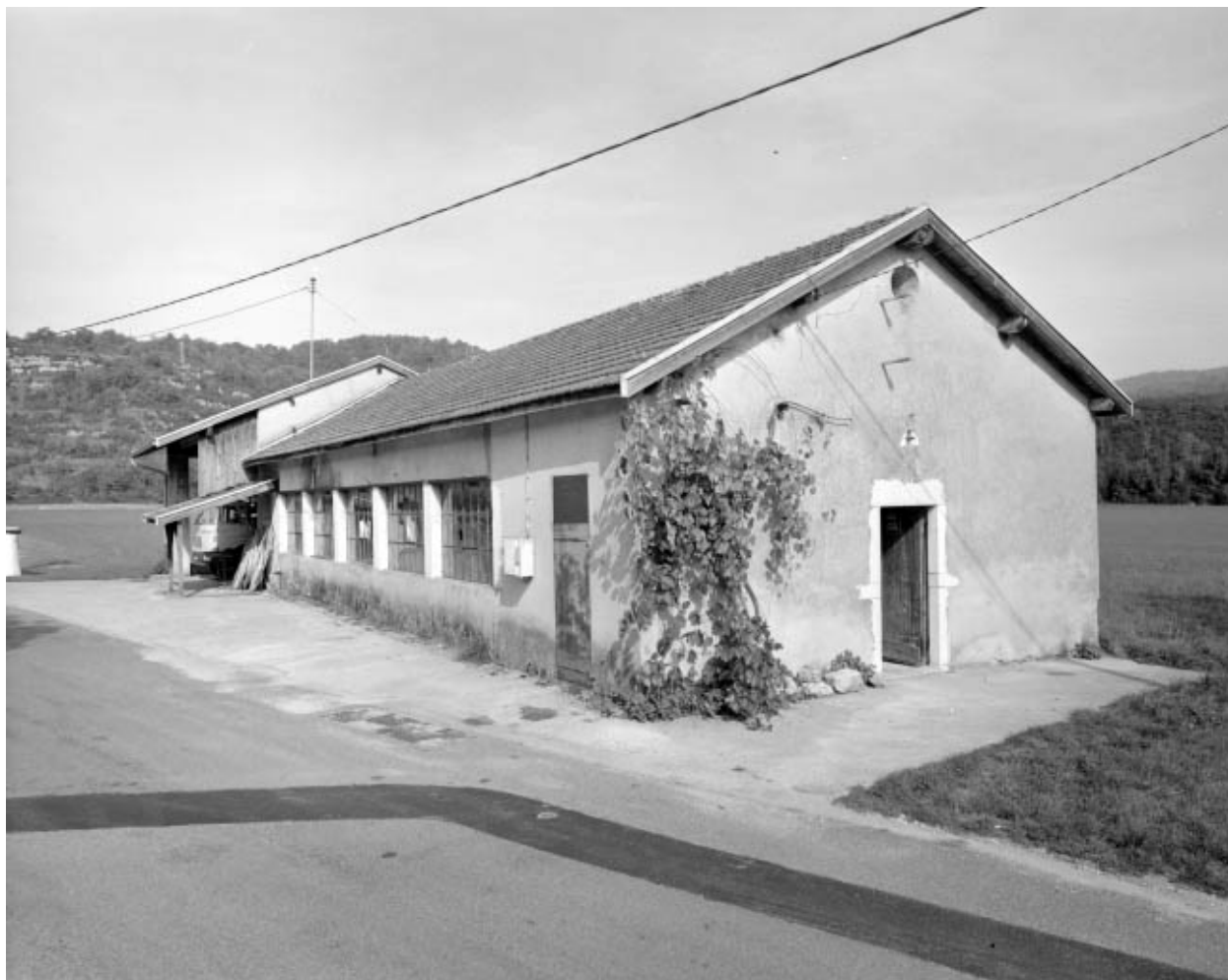
Façades antérieure et latérale droite.
