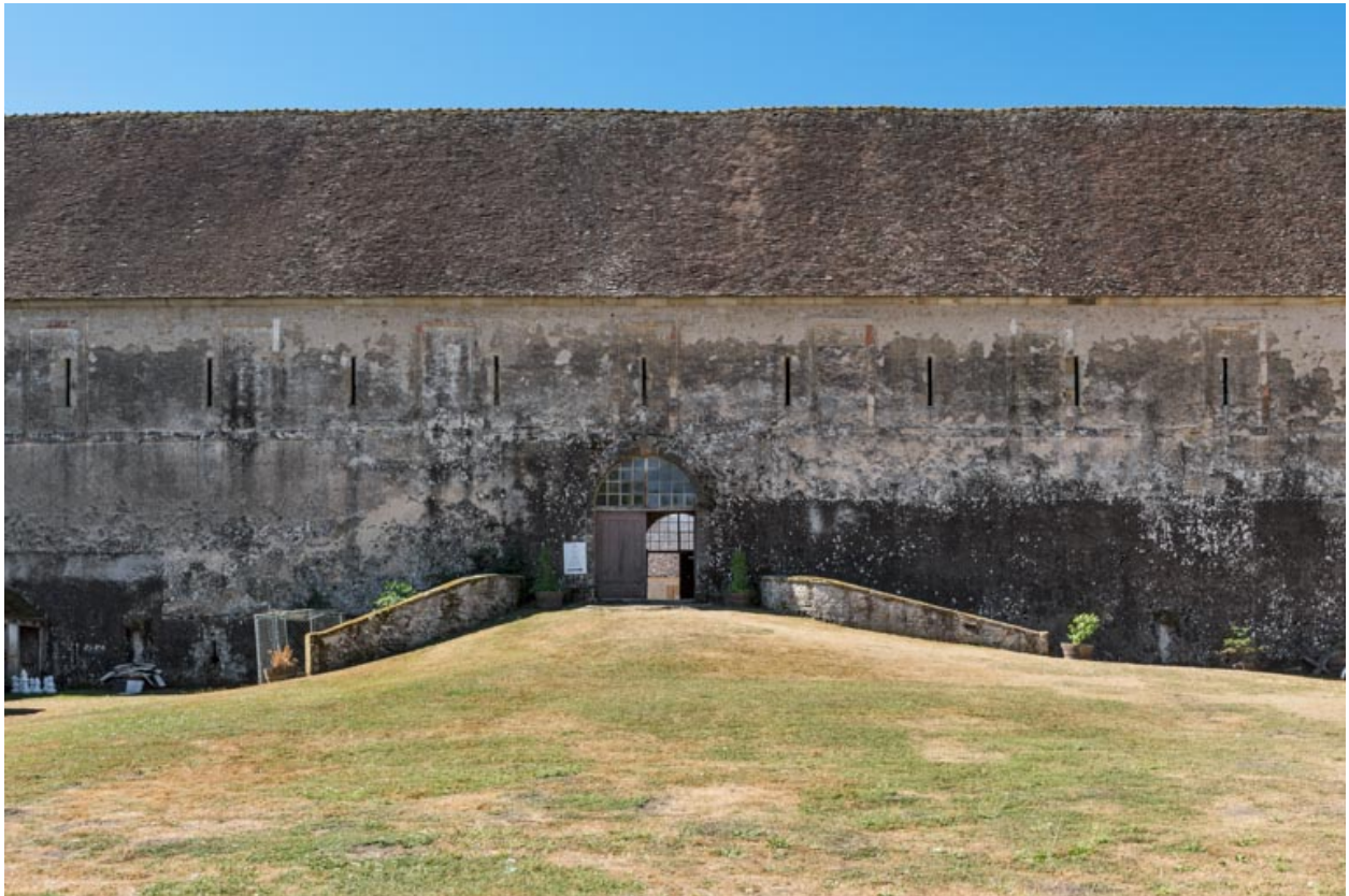
Façade postérieure : corps central.
