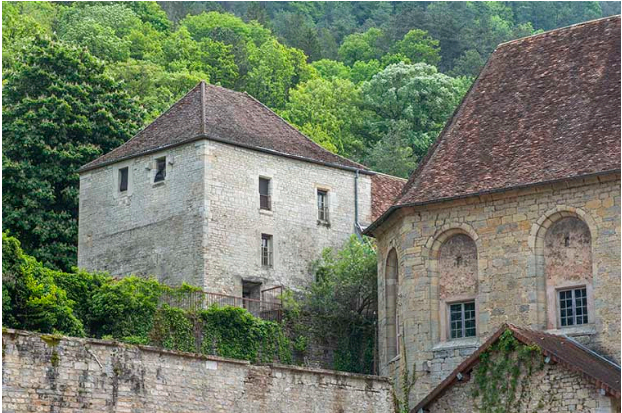
Vue d'ensemble de la tour Dorée.
