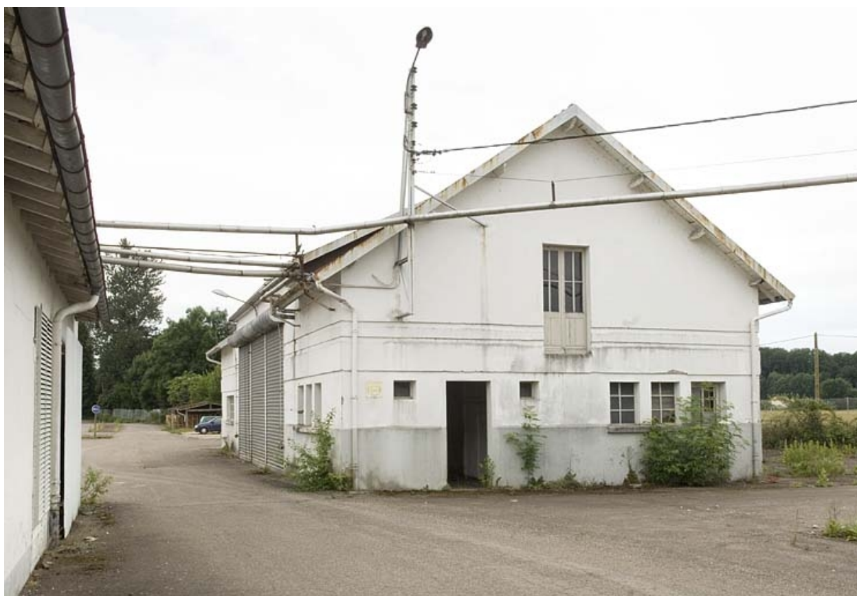
Garage à camions.
