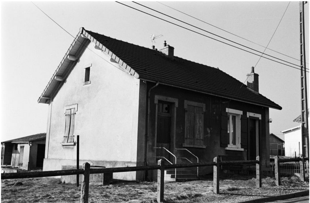
Habitation à deux logements de deux pièces de " type 5 " (1920-21).
