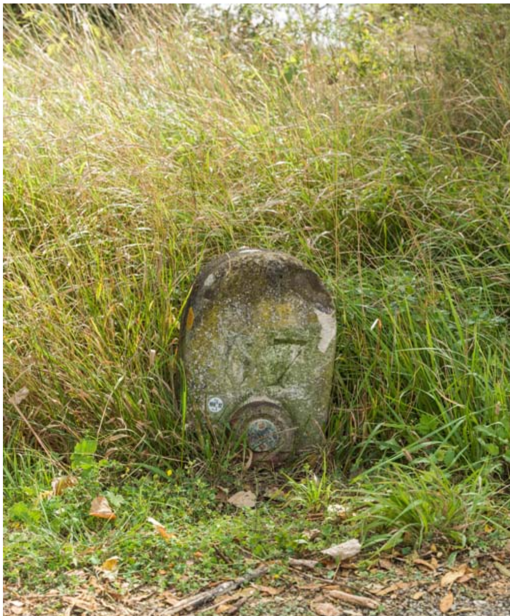
Vue d'ensemble de la borne.
