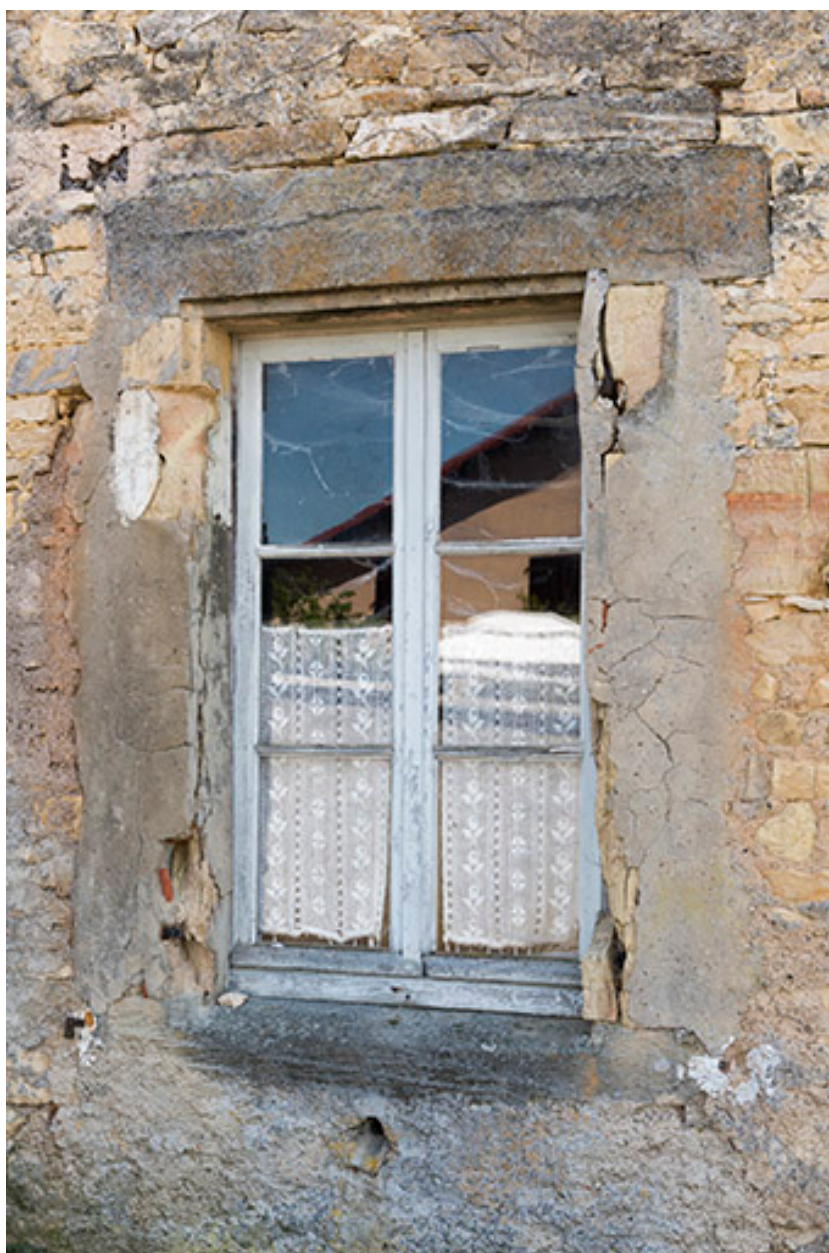
Détail d'une ouverture, mur pignon.
