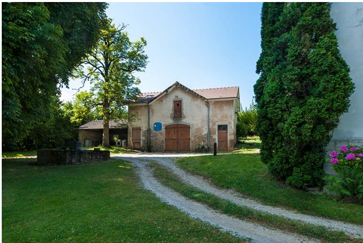
Annexe servant de garage : vue générale.
