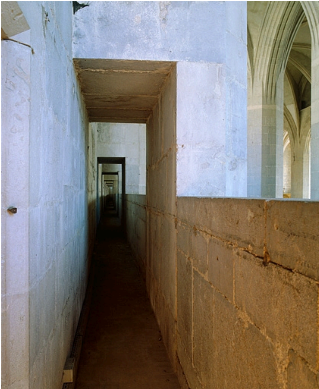
Passage établi au droit de la pile 1N dans la coursière du collatéral nord.
