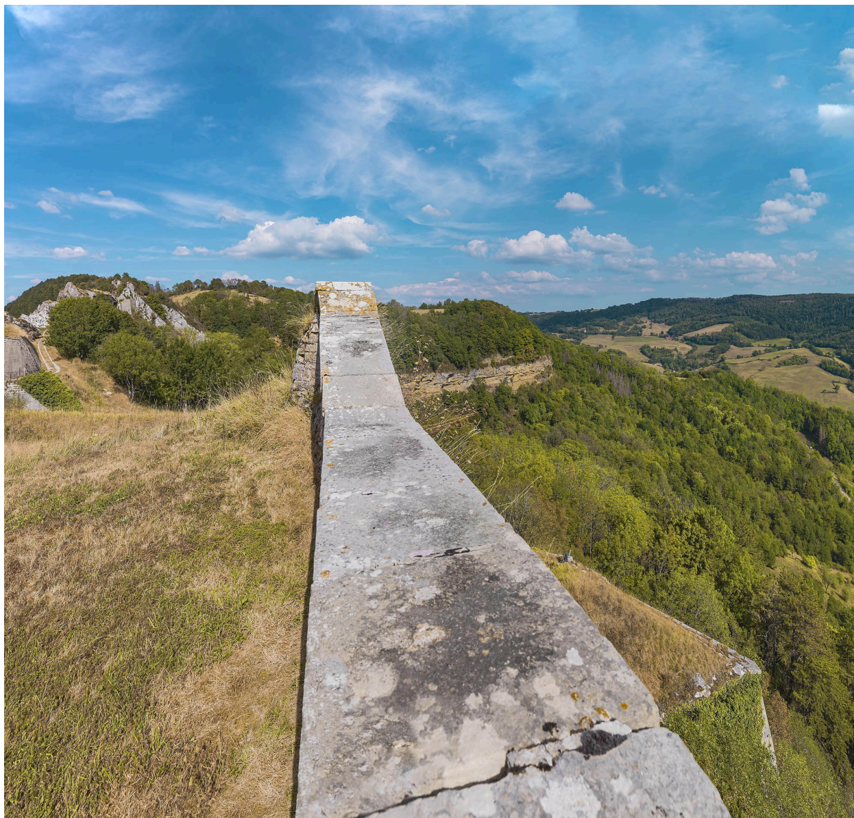
Parapet du front sud.
