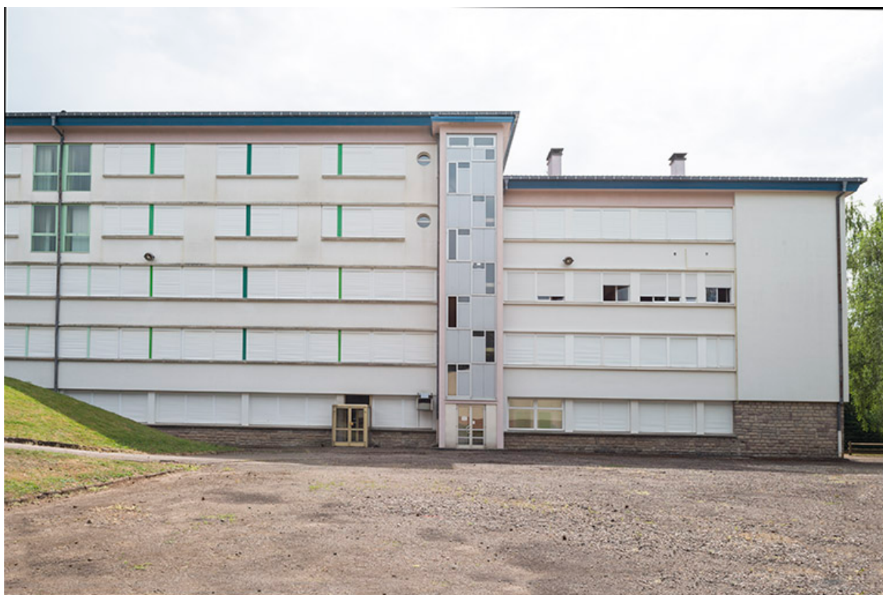
Externat : façade postérieure.
