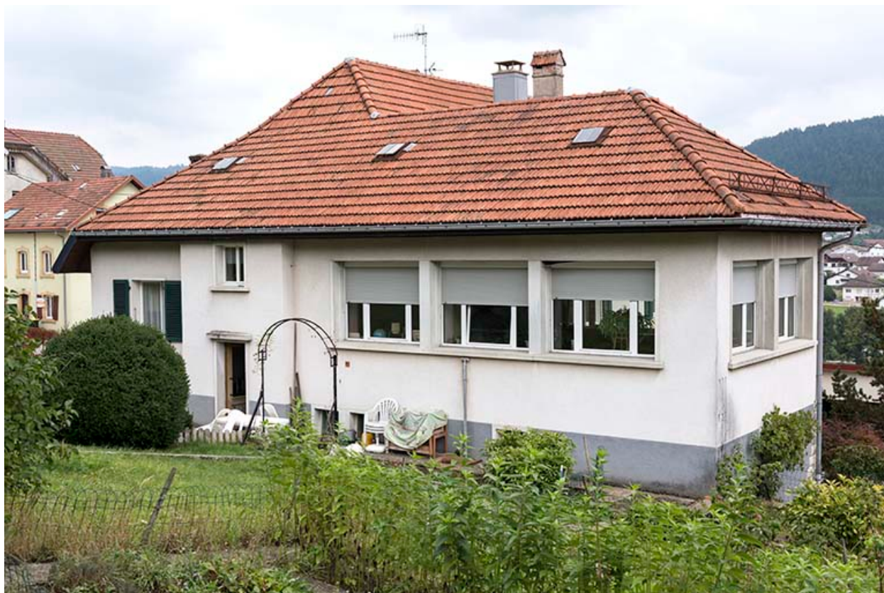
Façades postérieure et latérale gauche.
