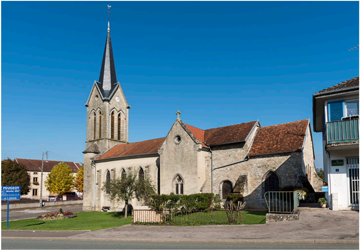
Vue d'ensemble sud-est.
