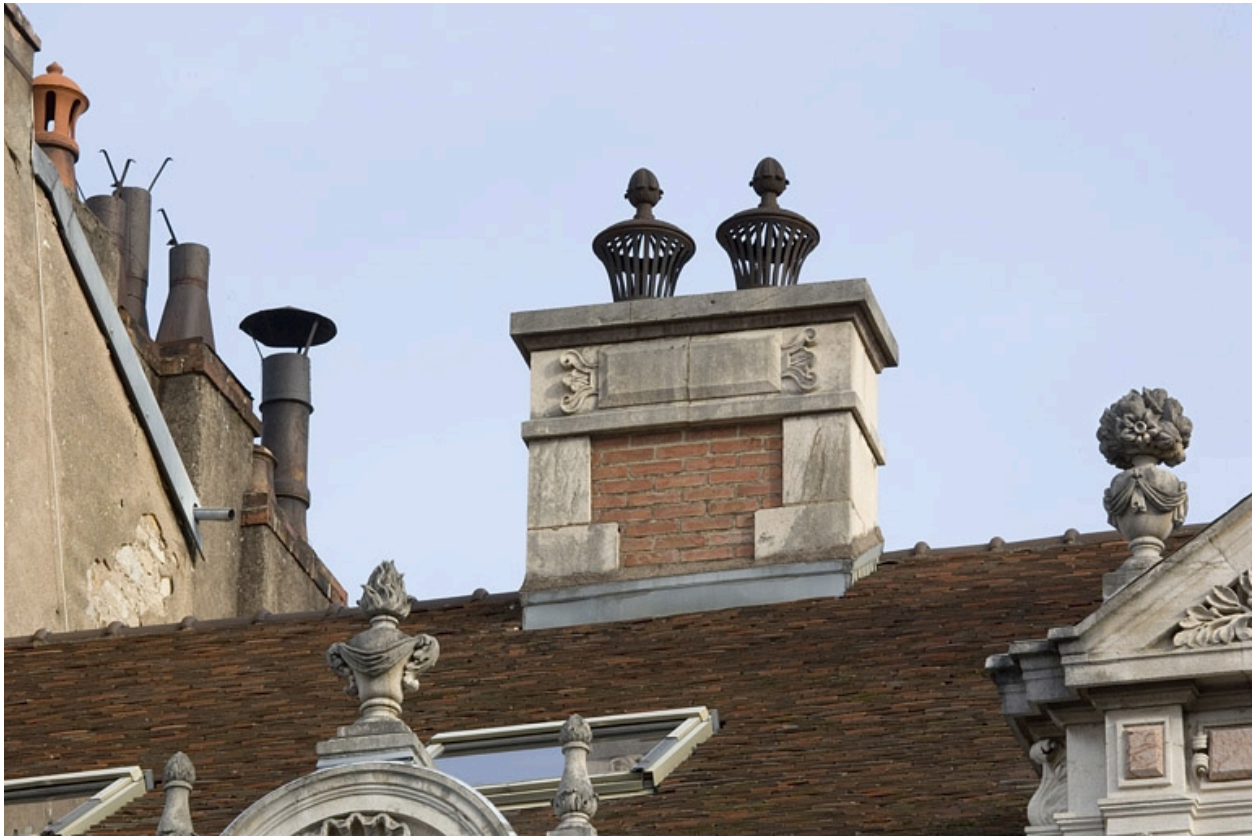
Détail d'une souche de cheminée.
