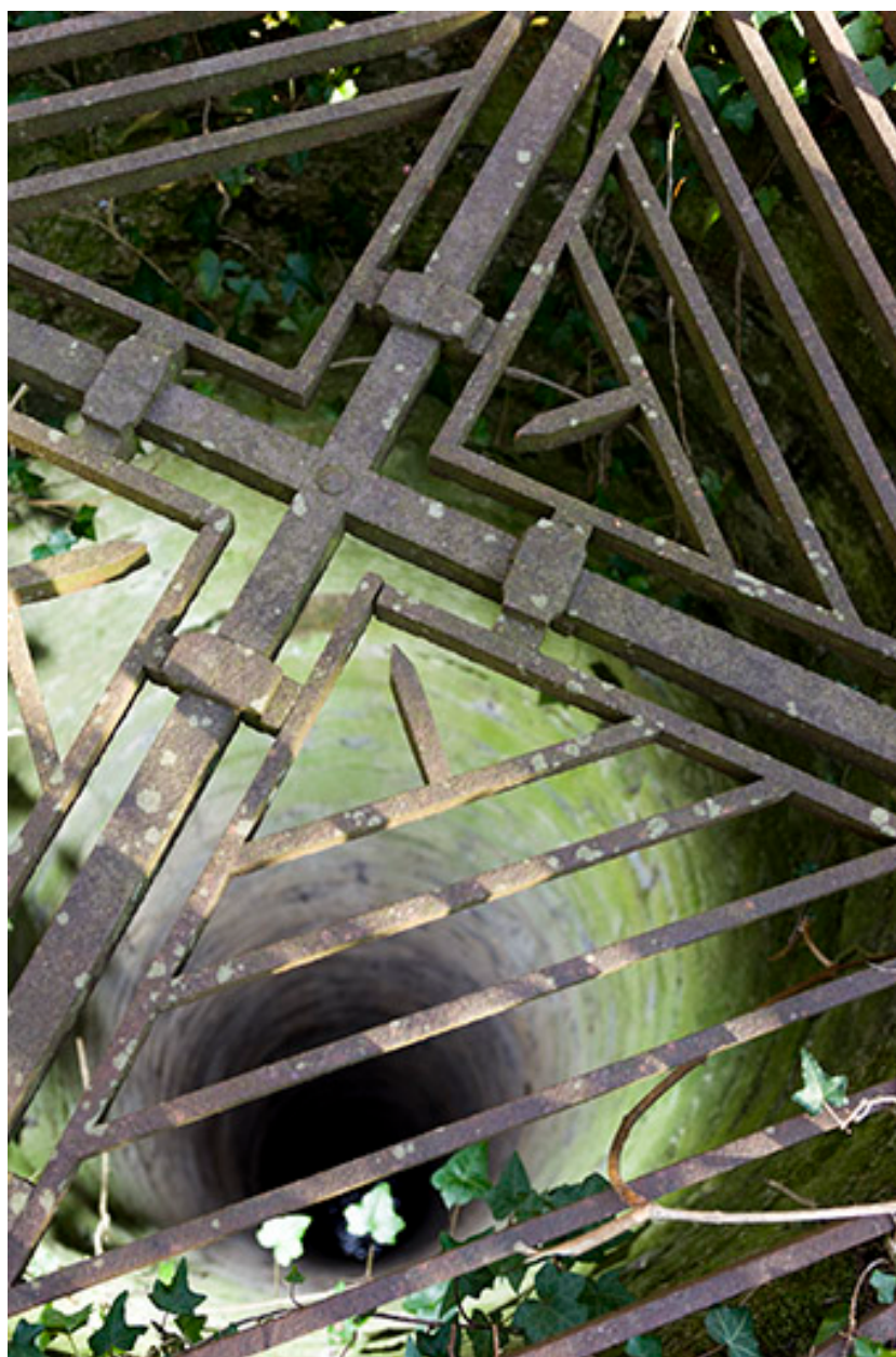
Vue du puits depuis l'orifice.
