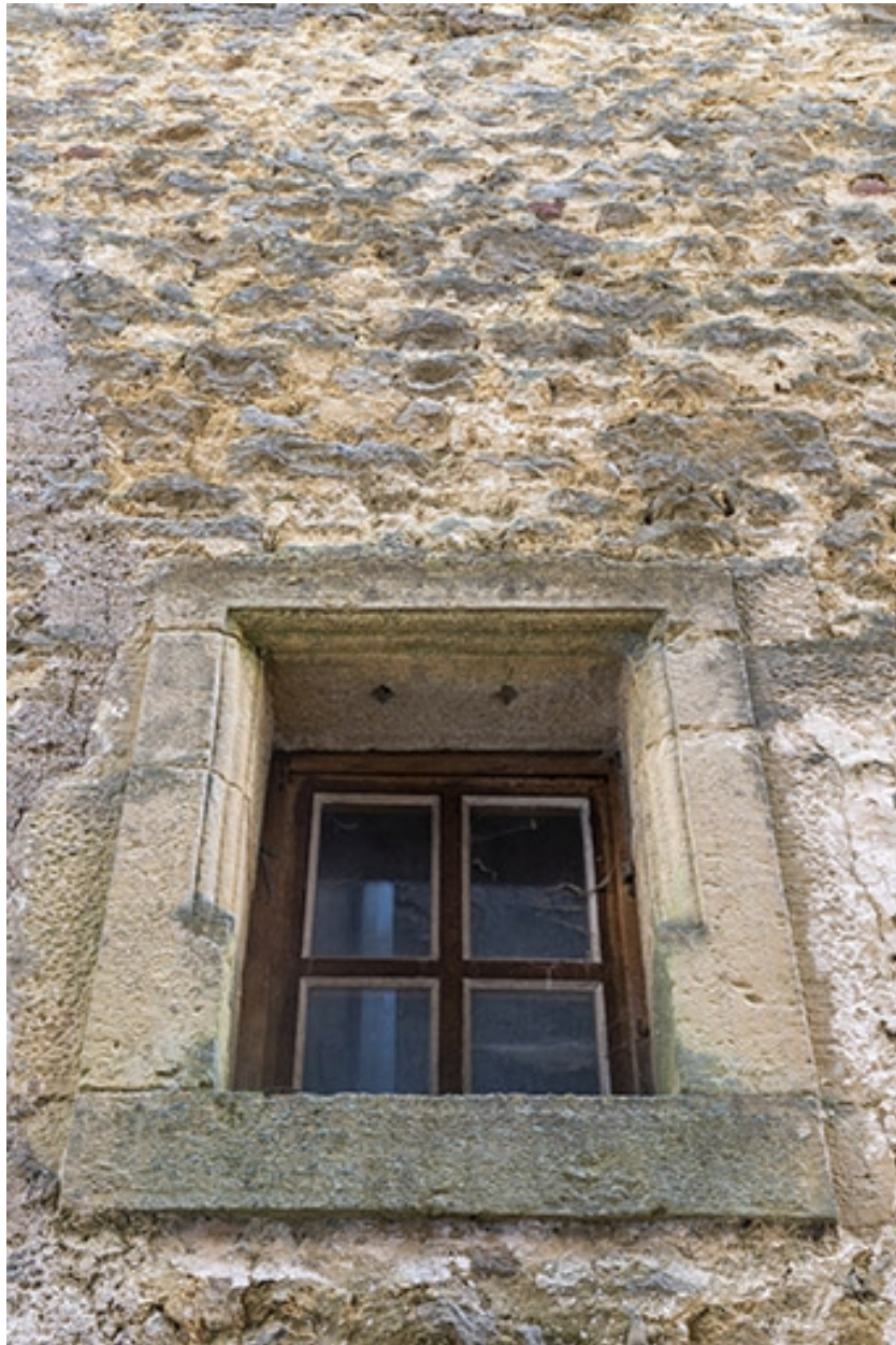
Une baie de l'étage, côté cour.
